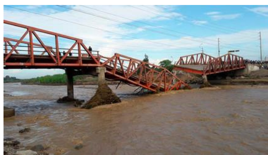
Figura 01: Colapso del Puente Viru – Trujillo por el fenómeno del Niño Costero 2017 (Cortesía: RPP)
